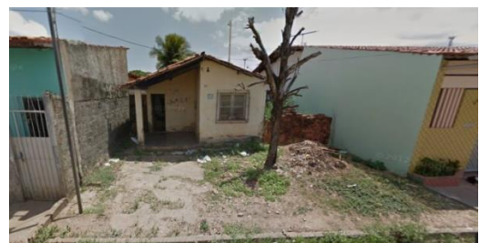
Figura 107 - Na rua 01 da unidade 203, casa original e sem muro, aspecto abandonado
