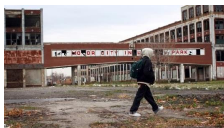
Figura 3 - Prédios públicos abandonados em Detroit – EUA.
