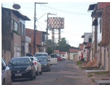
Figura 83 – Caixa D'água da Cidade Operária Fonte: Autora (2016)
