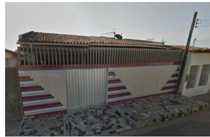
Figura 119 - Na rua 10 da unidade 203, exemplo dos acabamentos nas fachadas Fonte: Google Streetview (nov. 2011)
