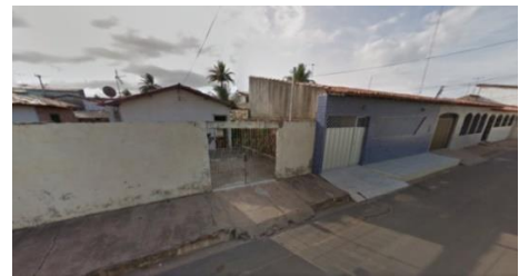
Figura 105 - Na rua 03 da unidade 103, casa do conjunto sem ampliação, apenas murada.
