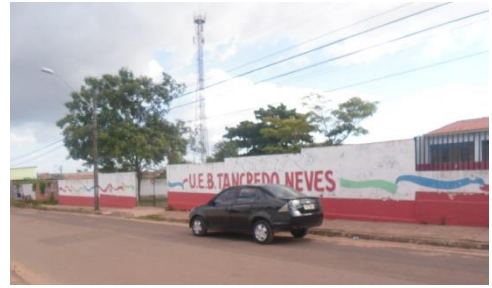
Figura 60 – U E. B. Tancredo Neves, na Av. Esteban 203. Fonte: Autora (2016)
